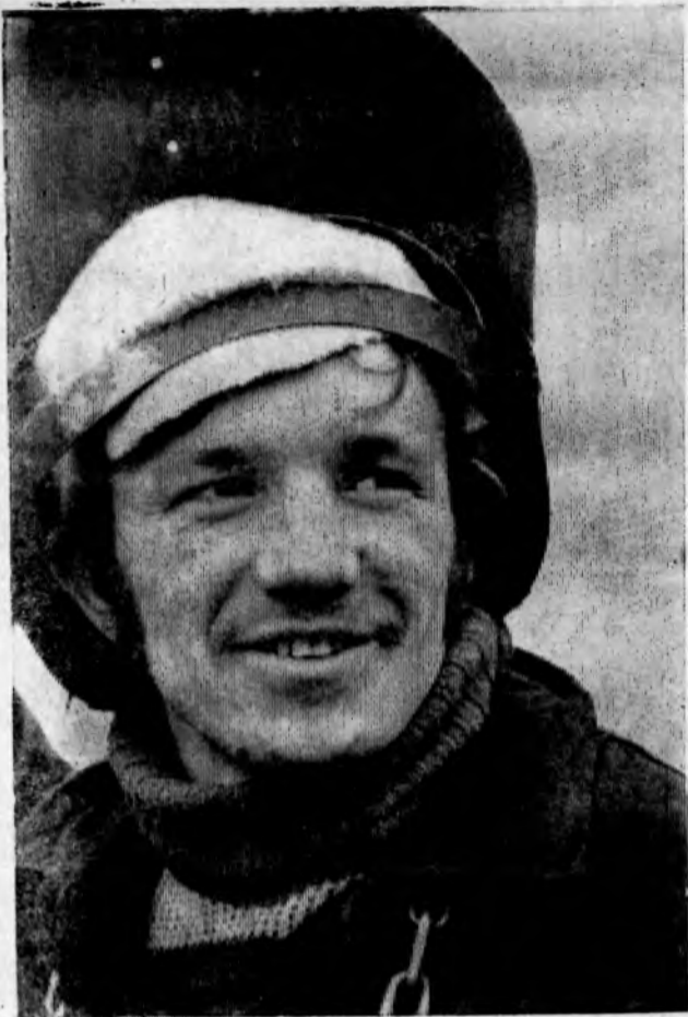
Комсомолец Иван Казмирчук (управление «Южпромвентиляция») ведет монтаж вентиляторов на главном корпусе Атоммаша. Вместе с товарищами он борется за то, чтобы план двух лет пятилетки выполнить к 60-летию Великого Октября.
